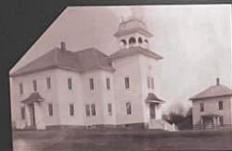
Cet édifice était situé près du 8920, route Linte-S.-St-Laurent (au coin du chemin Cochrane). L'école anglo-protestante Compton Model School se trouvait au rez-de-chaussée et l'hôtel de ville, considéré comme l'un des plus beaux de la région, occupait le premier étage. L'incendie du 21 décembre 1913 détruisit le bâtiment, une perte considérable pour la communauté comptonnaise.
